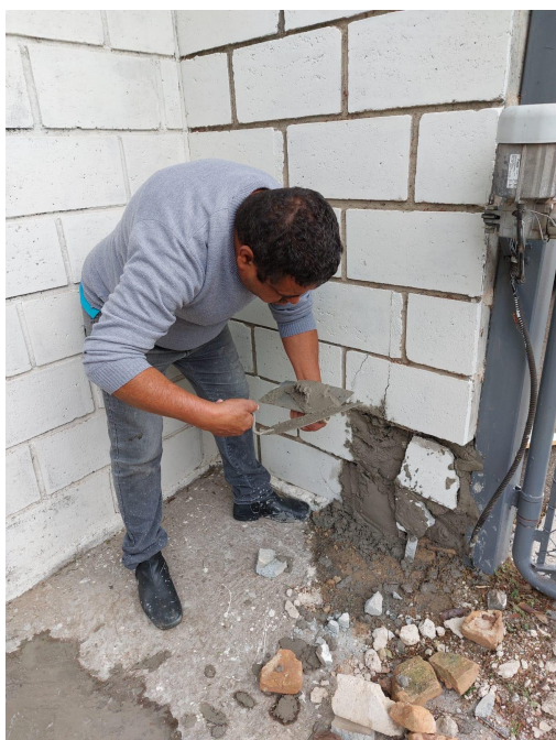
Manutenção provisória do muro de entrada
